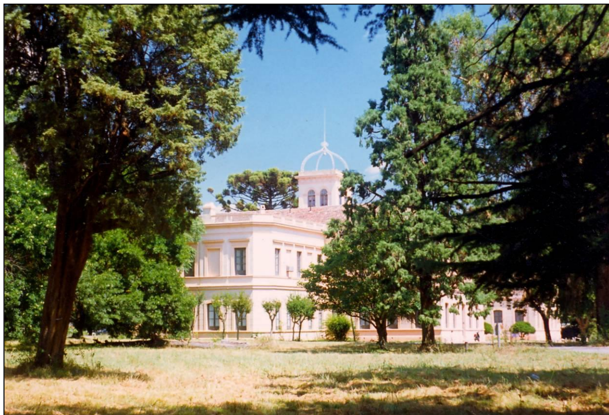
Figura 2. Edificio central de Santa Catalina (existente en la actualidad) que fue sede del Instituto Agronómico Veterinario (1883-1989), Escuela Práctica de Agricultura y Ganadería (1990-1916), Instituto Fitotécnico de Santa Catalina (1928-actual) y Rectorado de la Universidad Nacional de Lomas de Zamora (1978-2012). Foto: De Magistris, 1996.
