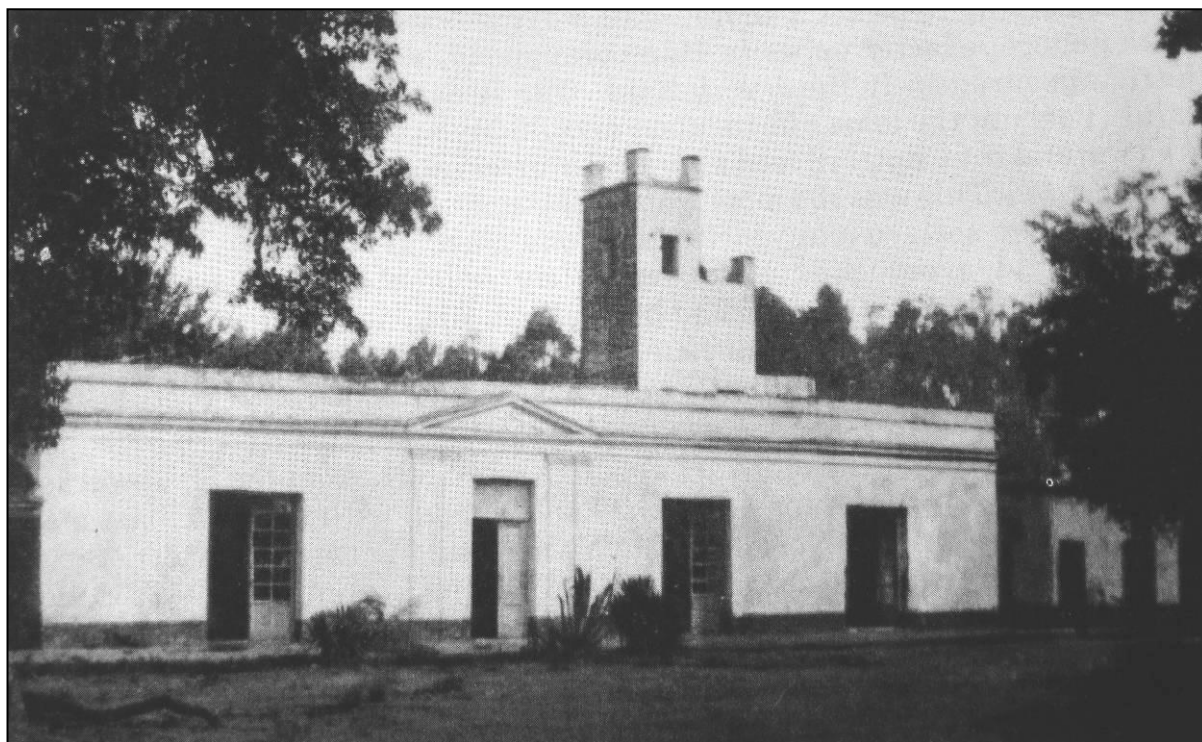
Figura 1. La única fotografía conocida del casco principal de Estancia Santa Catalina, que fuera sede de la Colonia escocesa de Santa Catalina. Fue demolido hacia fines del siglo XIX. Fuente: Cecilia Grierson (1925).
